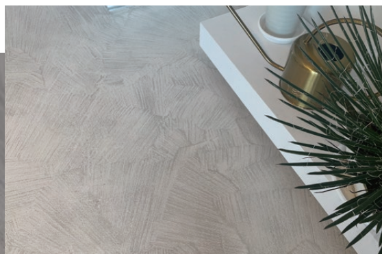
施工箇所: Floor
