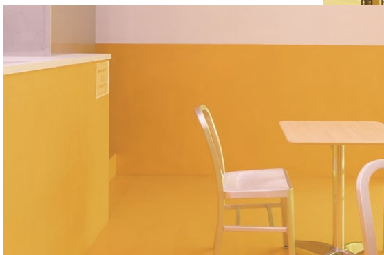
施工箇所: Floor & Spandrel Wall
