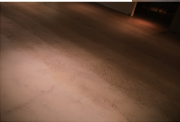
施工箇所: Floor
