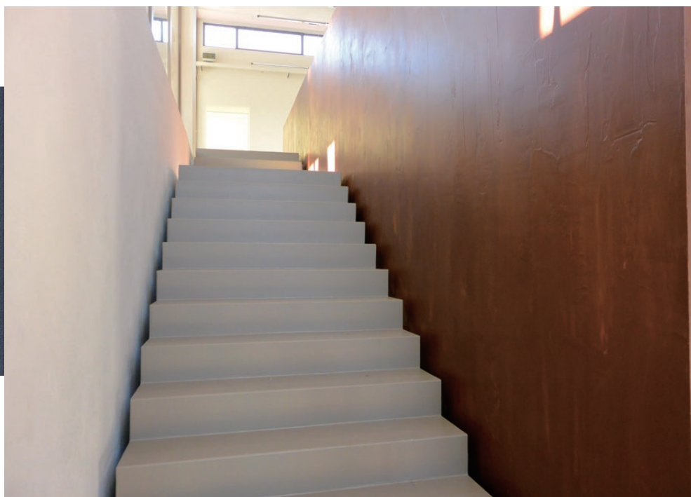
施工箇所: Wall & Staircase
