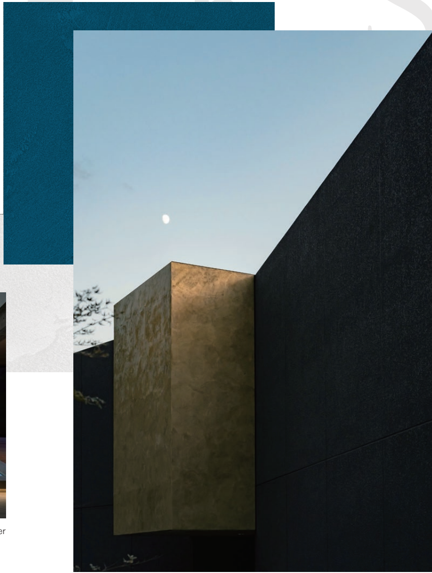
施工箇所:Facade
